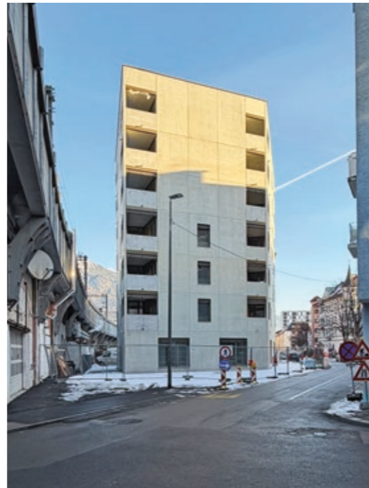
1 Wohngebäude mit sozialer Einrichtung, Vinzenzgemeinschaft St. Jakob, Innsbruck Foto aut
