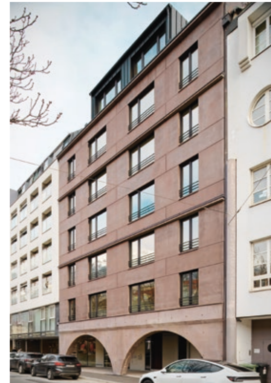
1 Stadthaus Innrain, Innsbruck Foto Lukas Schaller
