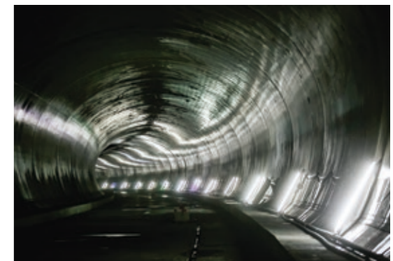
1, 2 Baustelle BBT Fotos BBT-SE
